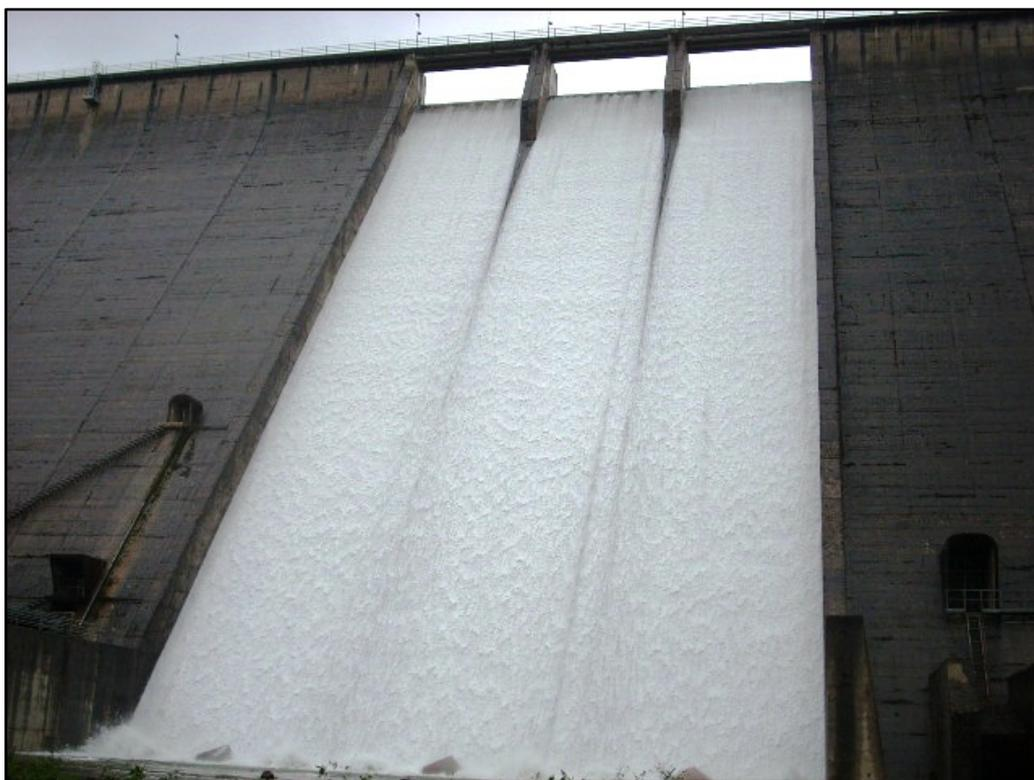
Figura 3.4.2 Scarico di superficie
