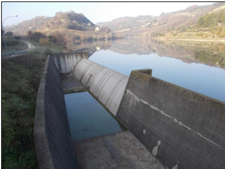
*Figura 3.5.3 – Scarico di superficie della diga di Rio Canale*
